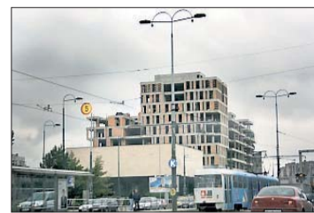
Sakte repareres Sarajevo.
